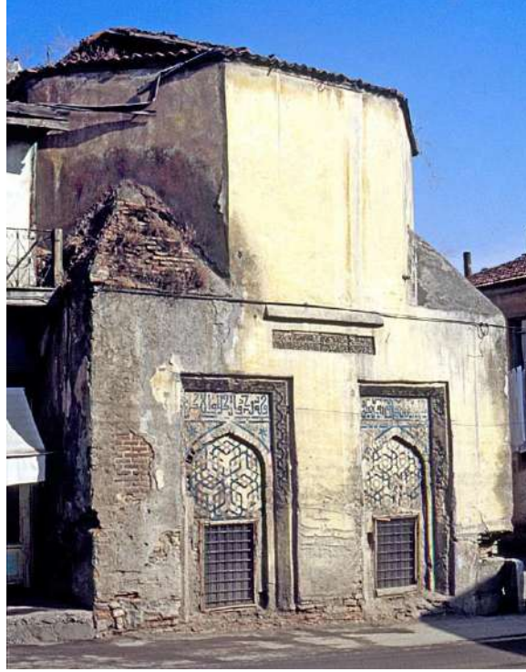
Görsel 2. Türbenin Restorasyon Çalışmaları Yapılmadan Önceki Görünümü ( https://islamansiklopedisi.org.tr/ebul-kasim-i-tusi-turbesi/ Erişim Tarihi:24.09.2023).
