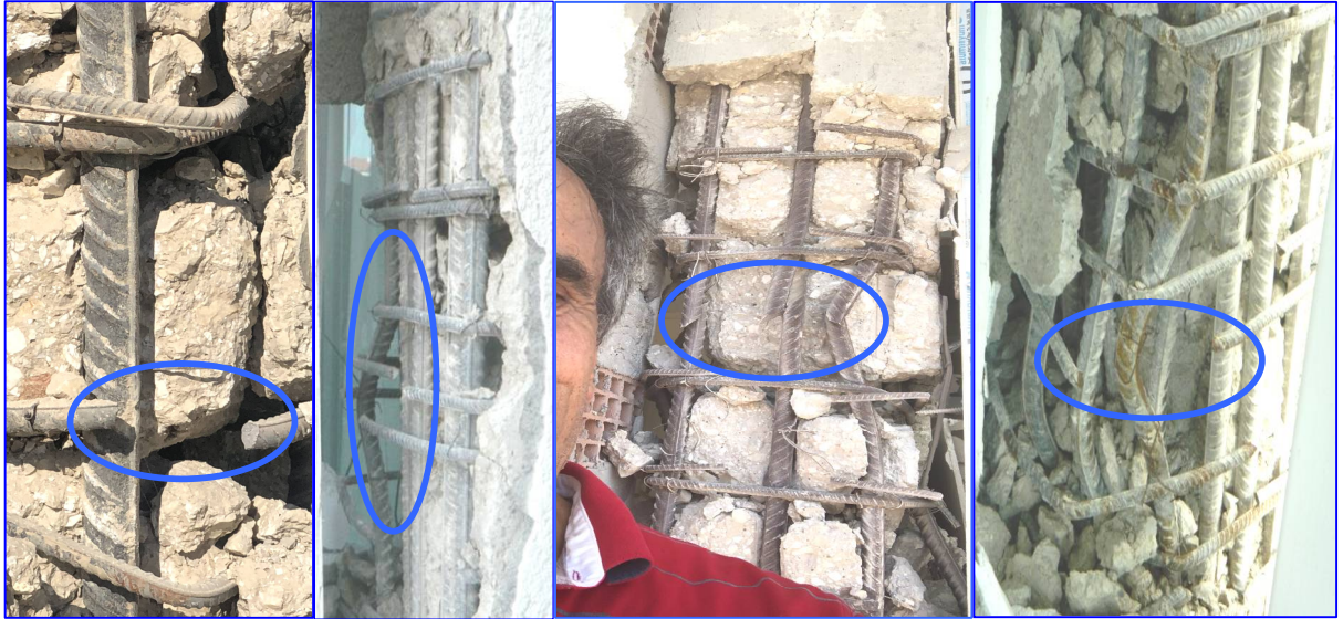
Görsel 10. Depremde kopmuş etriye ve boyuna donatı örnekleri
