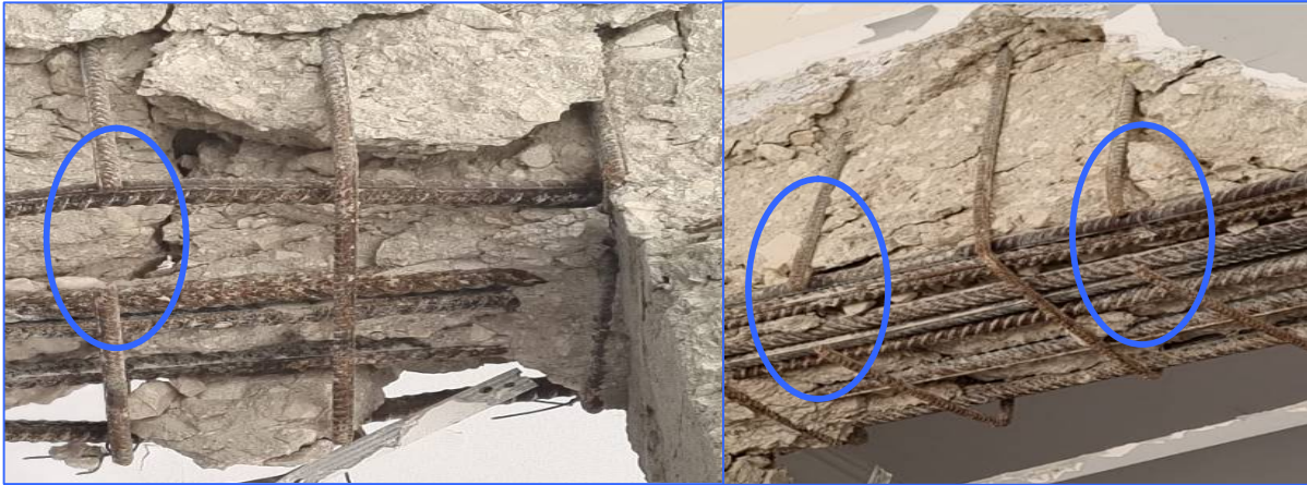
Görsel 1. Depremde etriye hasarı
