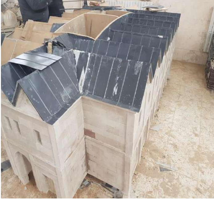
Görsel 3. Yapının çatısının kapatılması (Korkmaz,2020)
