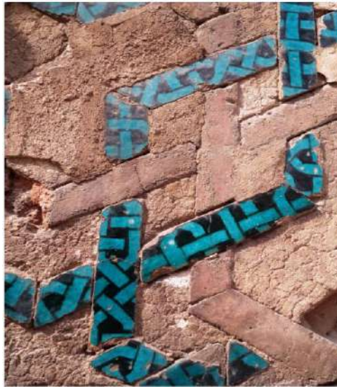
Görsel 4. Tokat Ali Tusi Türbesi’ndeki Pencereden, Tuğla ve Çini ile Oluşturulan Süsleme Detayı (Elpe, 2015, 67, Foto: 15).
