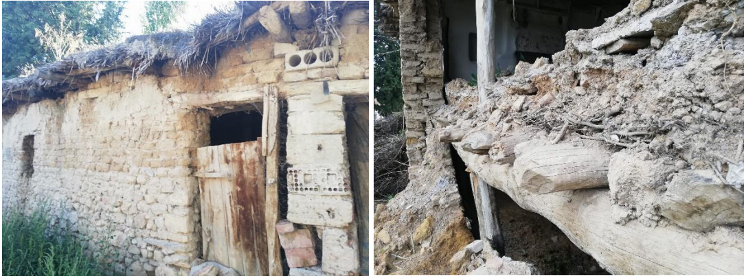
Görsel 11. Kocayaka Köyü Çatı Aksamında Saz ve Çalı Çırpı Kullanımı
