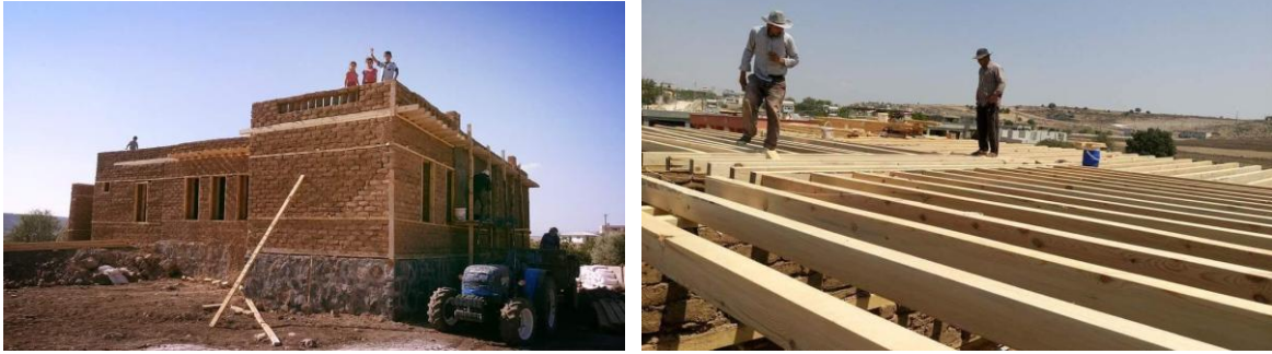
Görsel 5. Çatı Yapımı 22
